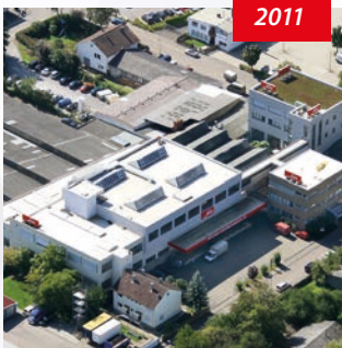
Vue aérienne du site, Bietigheim-Bissingen
